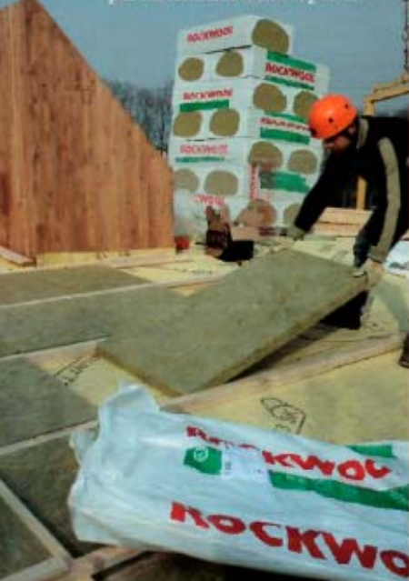
Posa del pannello in lana di roccia per l'isolamento della copertura
