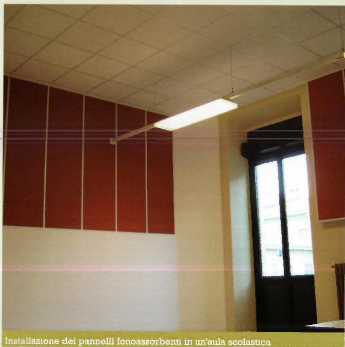
Installazione dei pannelli fonoassorbenti in un'aula scolastica
